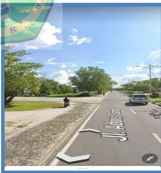
Sta 0+000 Jalan Lamtoro Gung
