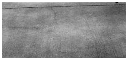
Gambar 2. 18 Tingkat kerusakan Retak susut ( shrinkage cracks ). (ASTM, 2007)
